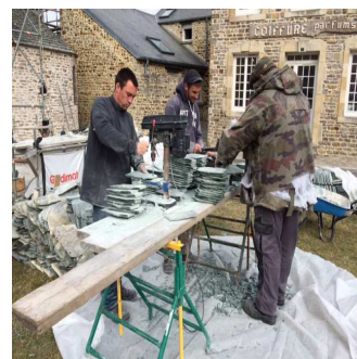
La Société Falaisienne de Couverture remplace les ardoises de la couverture de Notre-Dame
